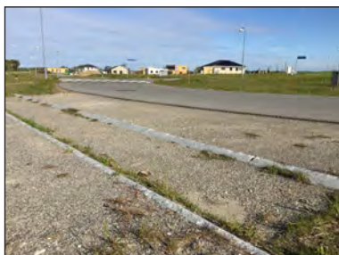
Eksempel fra lokalplanområdet på åben rende til afledning af regnvand
